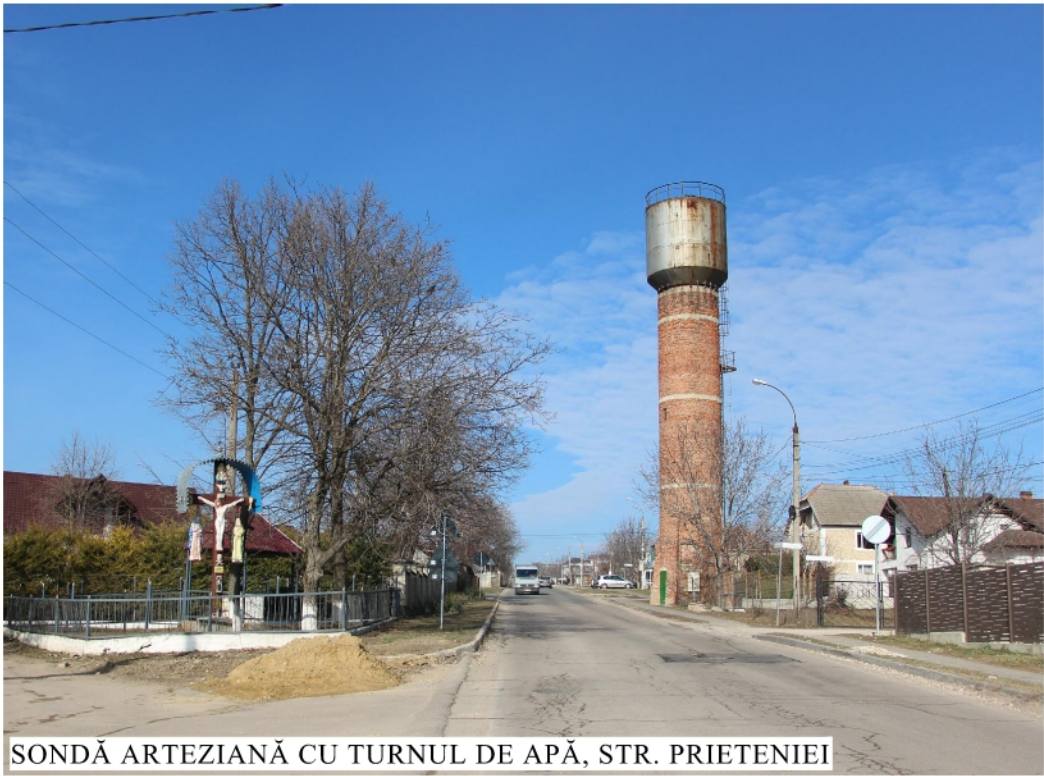
SONDĂ ARTEZIANĂ CU TURNUL DE APĂ, STR. PRIETENIEI
