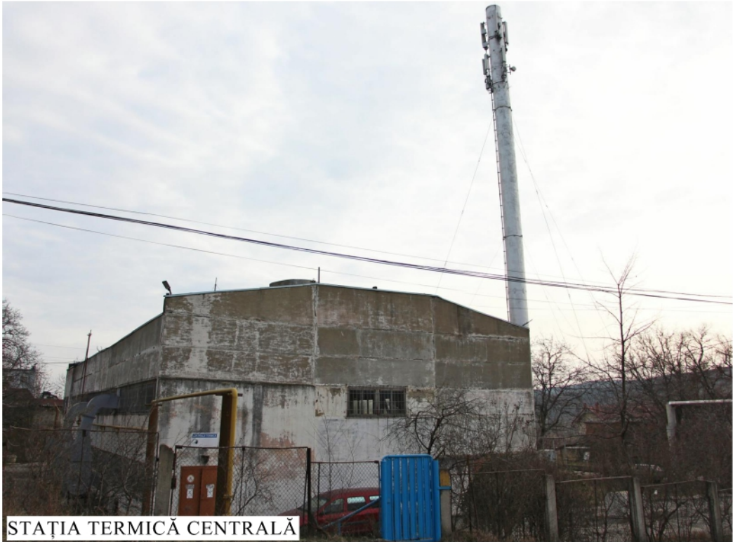
STAȚIA TERMICĂ CENTRALĂ
